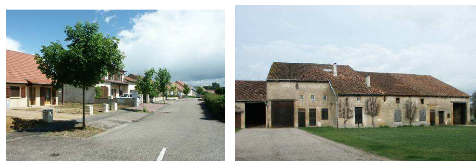
Des actions positives pour les paysages se développent depuis quelques années : lotissements cohérents, en référence à l'identité architecturale lorraine et prenant en compte la qualité de vie, réhabilitation du patrimoine bâti et arboré villageois.
