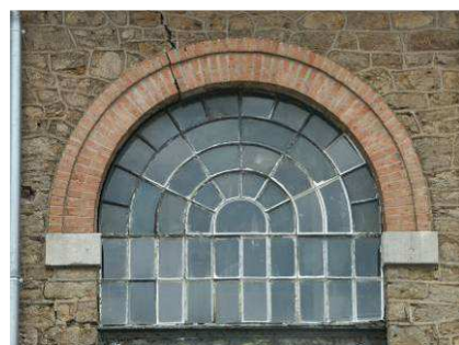
Les anciennes mines de fer ont donné lieu à de belles architectures mêlant la brique, la pierre et le verre. (ex : mine de Jarny)
