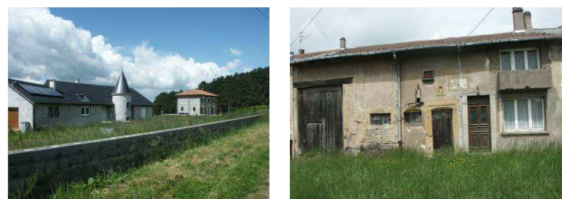
Les coeurs des villages ont connu une phase d'abandon, tandis que des lotissements à l'architecture disparate se développaient.
