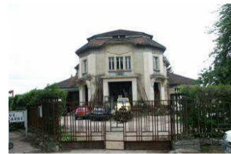
Ancienne salle des fêtes de Giraumont à réhabiliter.
